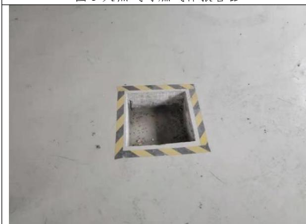
图 7 化学品库房泄漏收集装置
