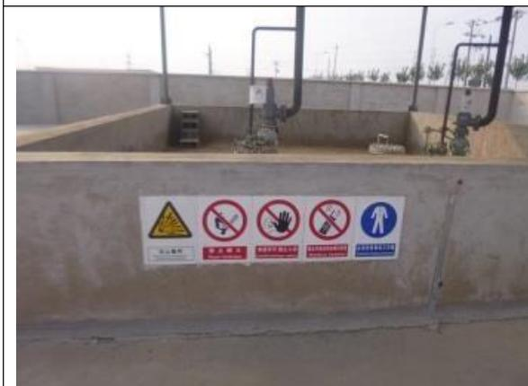
图 3 丙烷罐区围堰
