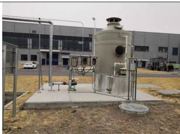
图 2 液氨存储设施泄漏吸附装置
