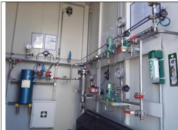
图 1 液氨存储设施有毒气体泄漏报警器
