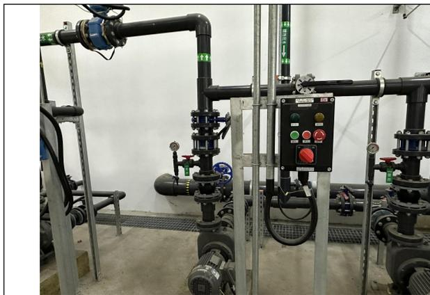
图 15 废水总排口截止阀
