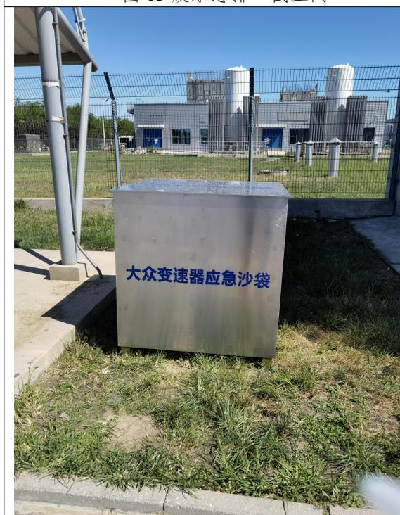
图 17 雨水排口应急沙箱
