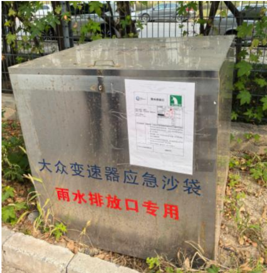
雨水排口张贴简易处置卡且配备开盖拉钩（拉钩在箱子内）
