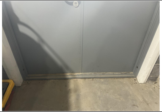
危废间防溢流门槛
