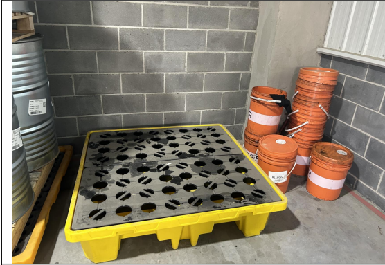
危废暂存间地面托盘
