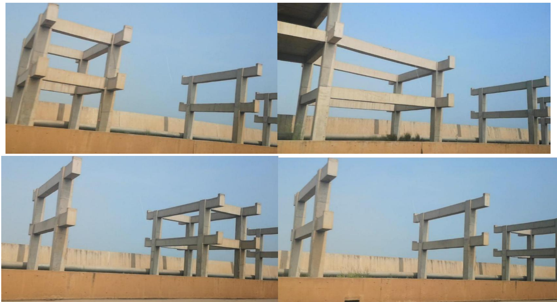
图 3.3-27 已建管廊架
