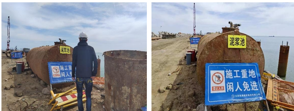
图 5.2-1 施工现场泥浆池
