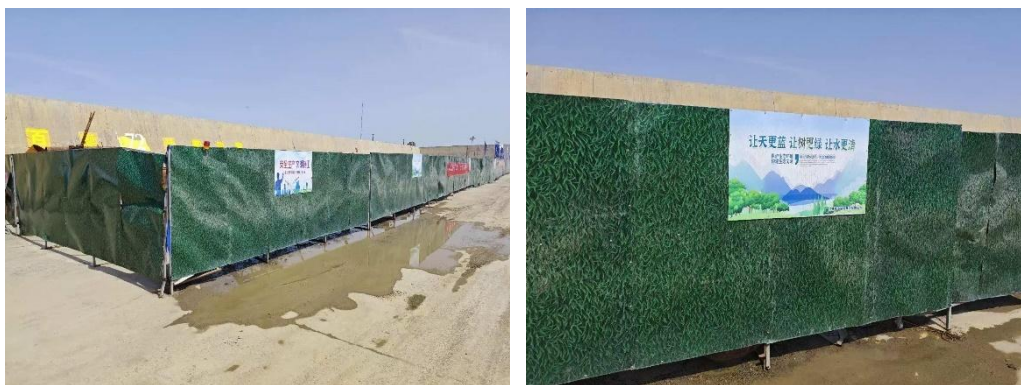
图 5.2-7 设置了施工围挡
