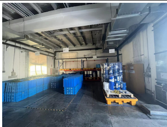
危险废物暂存间（内部）
