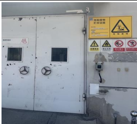
危险废物暂存间及环保标识牌
