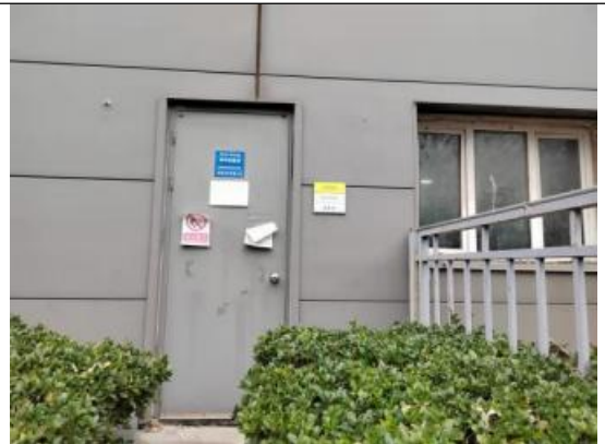
柴油油料储藏室
