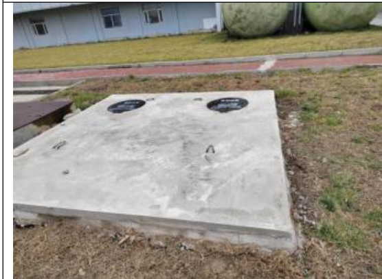
应急水罐的泵壳
