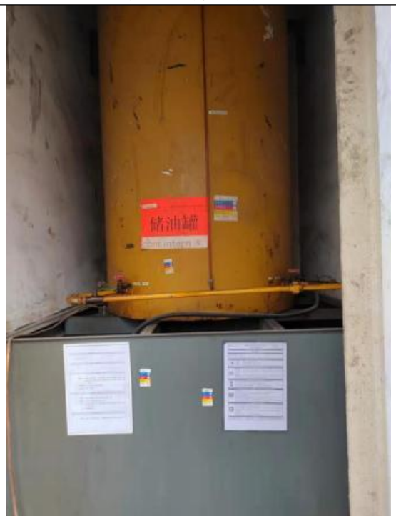
柴油油料储藏室
