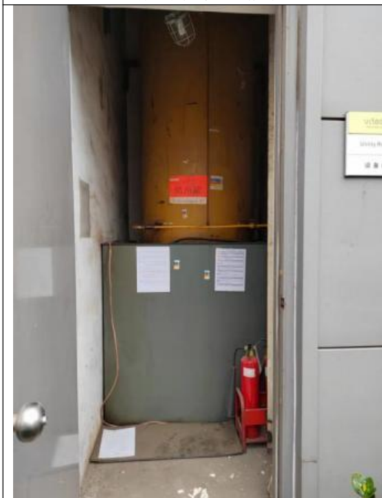
柴油油料储藏室
