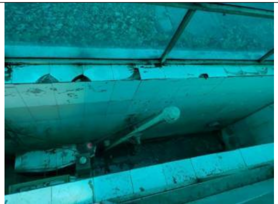
厂区废水总排口溢流堰
