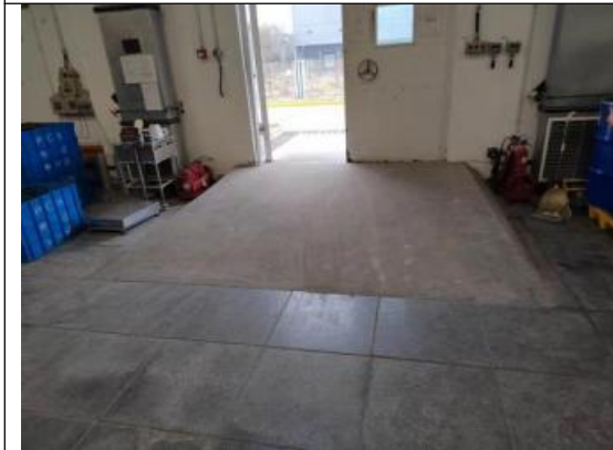
危险暂存间缓坡及报警装置
