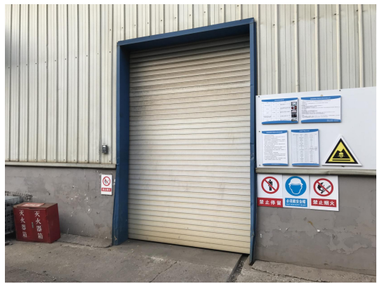
图 1 危险废物暂存场所
