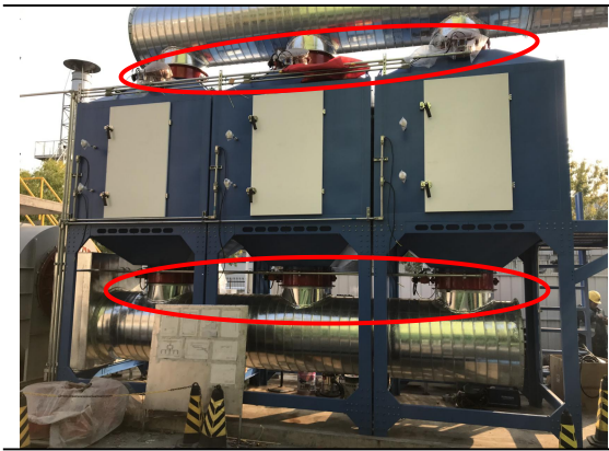
图 5 管道软连接
