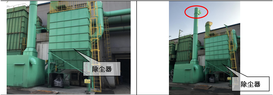
图 5 落砂输送至砂处理废气除尘器（TA009） 图 8 落砂输送至砂处理废气排气筒 DA009
