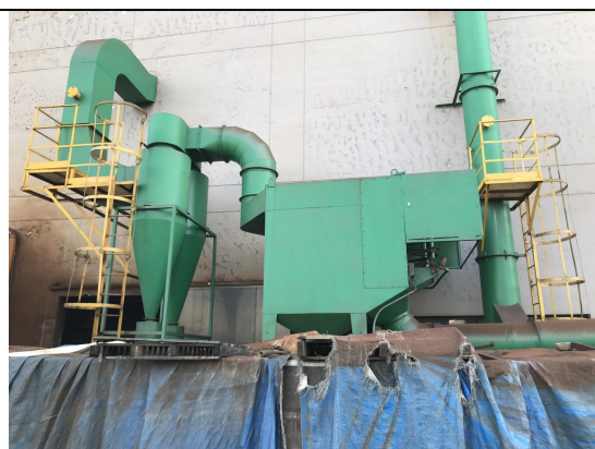
图 5 滤芯式除尘器（TA008）
