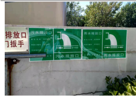
图 17 废水总排放口标识牌
