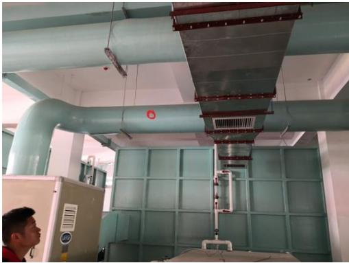
生化池臭气除臭装置+风机隔音
