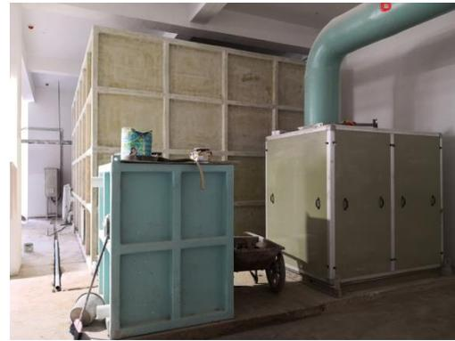
脱泥间臭气除臭装置+风机隔音
